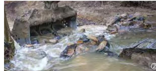
Der begradigte Lauf, der mit einem Block gestopft werden sollte, wurde abgefischt, ② dann wurden Kies und Steine mit dem Bagger hinter dem Beginn der neuen Schlinge zu einem Wall aufgehäuft. Steht genügend Kies zur Verfügung, kann die neue Schlinge bereits aktiviert werden.
