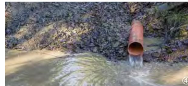
Ist die neue Schlinge lang, muss man sicherstellen, dass der Abfluss im Gewässer während der Aktivierung nicht abreißt. ④ Dafür kann ein Rohr im Block einen Mindestabfluss gewährleisten; es wurde nach Aktivierung wieder ausgebaut.
