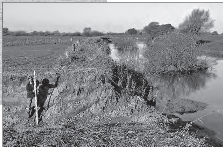
Die fast zwei Meter hohe künstliche Verwallung der Lippe wurde durchbrochen. (fotografiert am 29.10.2005)
