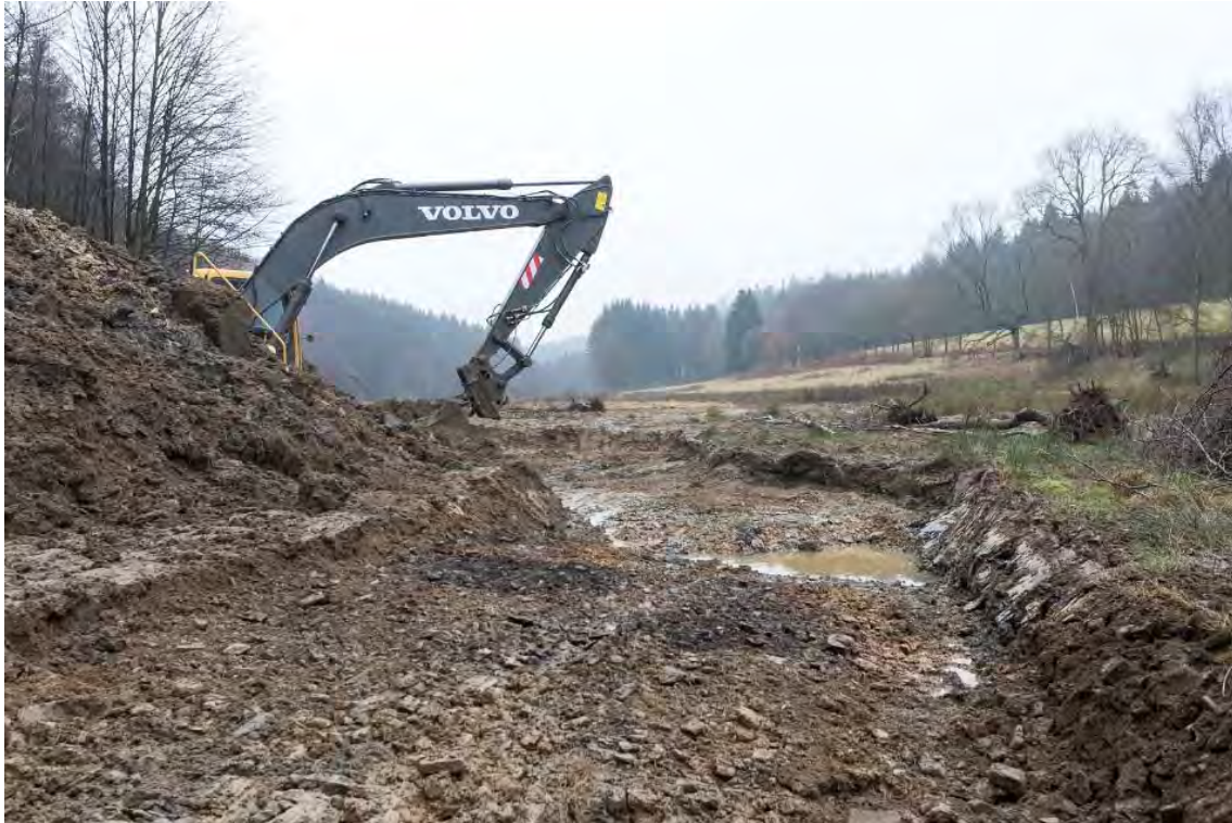
Abb. 53: Im Unterlauf der Großen Schmalenau ist der Auelehm nur wenige Dezimeter mächtig. Für die Neutrassierung kein Problem: Er wurde im Januar 2013 auf der neuen Trasse bis auf den Tal-kies abgekratzt und zum Verstopfen des vormaligen, begradigten und erodierten Laufes verwendet.
