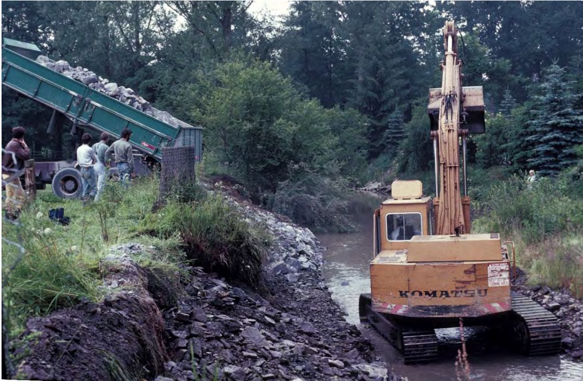
Abb. 27: Befestigung eines Uferabbruches an der Heve bei Wilhelmsruh 1988
