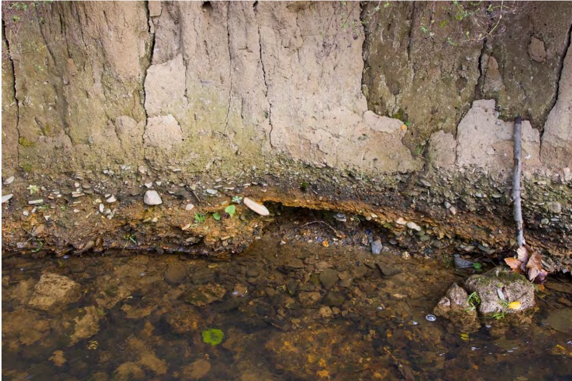
Abb. 9: Auehm kann die seitliche Verlagerung von Gewässern so stark behindern, dass einmal vorhandene Mäander nur noch extrem langsam wandern. Oft beginnt eine laterale Erosion in den weniger kohäsiven Kiesschichten unter dem Lehm, der dann unterspült wird und in Blöcken abbricht (Möhne östlich Belecke).
