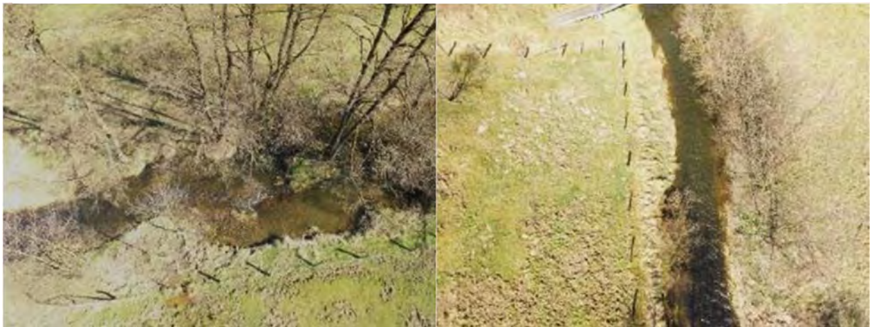
Abb. 5.4-82: Möhne bei km 47,65: Seitenerosion und Kiesbänke im Bereich von Ufergehölzen, 23.03.2017
