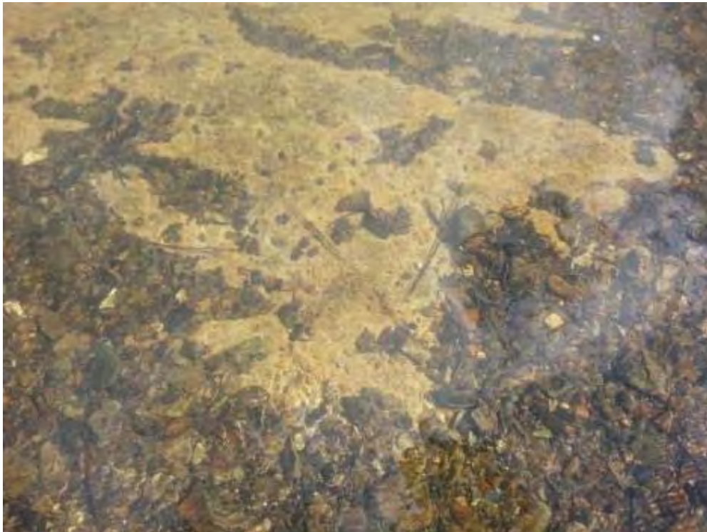
Abb. 5.4-51: Sohle in Probestrecke 13, km 31,0. Der gewachsene Auelem blockiert die Entstehung von Kiesstrukturen im darunterliegenden historischen Kies, 31.3.2020.
