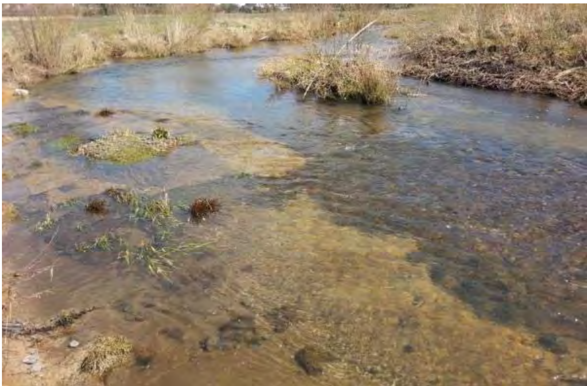
Abb. 5.4-52: Probestrecke 13 bei km 31,3. Hier liegt die neue Sohle teilweise in einer Auelehm-schicht. Eingeschwemmter Kies kann sich nur schlecht halten, 31.3.2020
