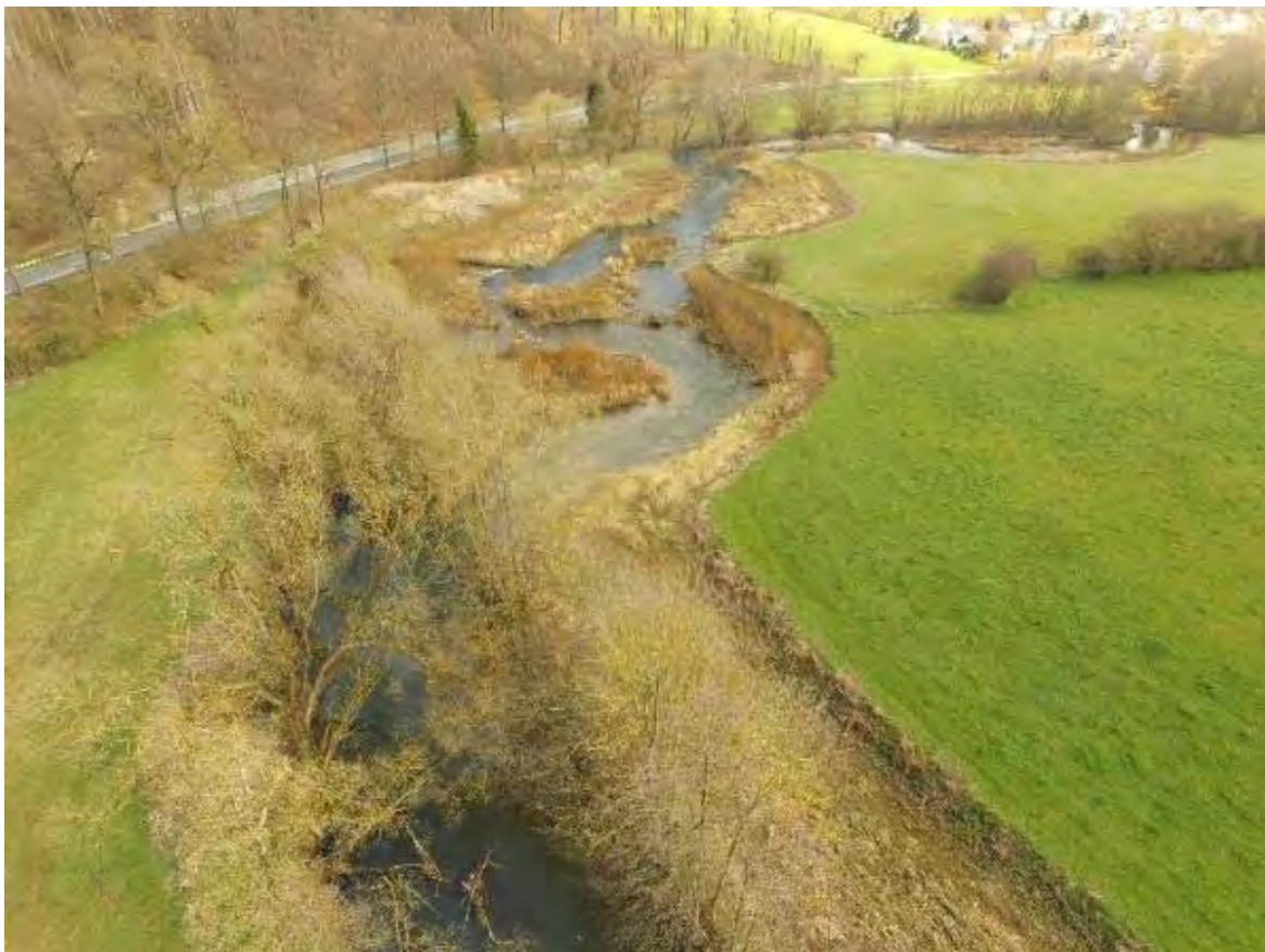
Abb. 4.1-3: Überblick über einen gut zu befliegenden Gewässerabschnitt (Ersatzaue der Möhne bei Allagen (Blickrichtung aufwärts))
