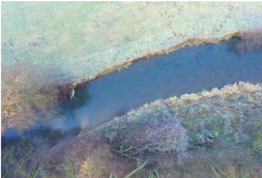
Abb. 5.4-32: Möhne bei km 25,25: Blick auf die Sohle aus der Luft, 29.11.2016
