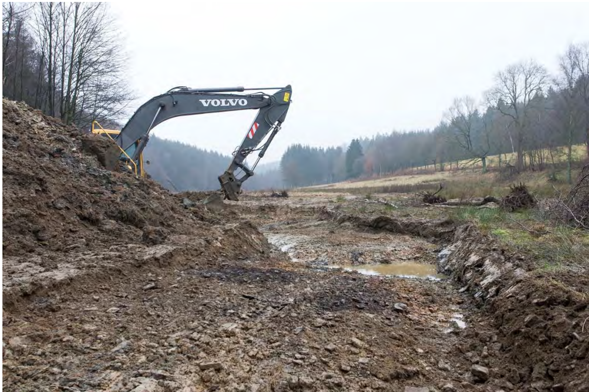
Abb. 3.2-3: Das neue, flache Bett der Großen Schmalenau wird durch Entnahme einer wenige Dezimeter mächtigen Auelehmauflage auf dem Talkies ausgebildet.
