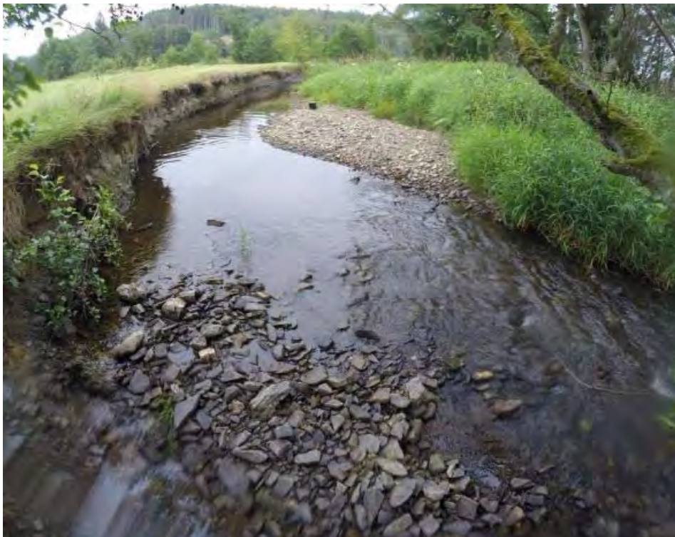
Abb. 5.4-77: Probestrecke 23 bei km 47,2. An einer langgezogenen Abbruchkante wird Kies mobilisiert. Hochwasser haben eine seitliche Kiesbank und eine Querbank gebildet.
